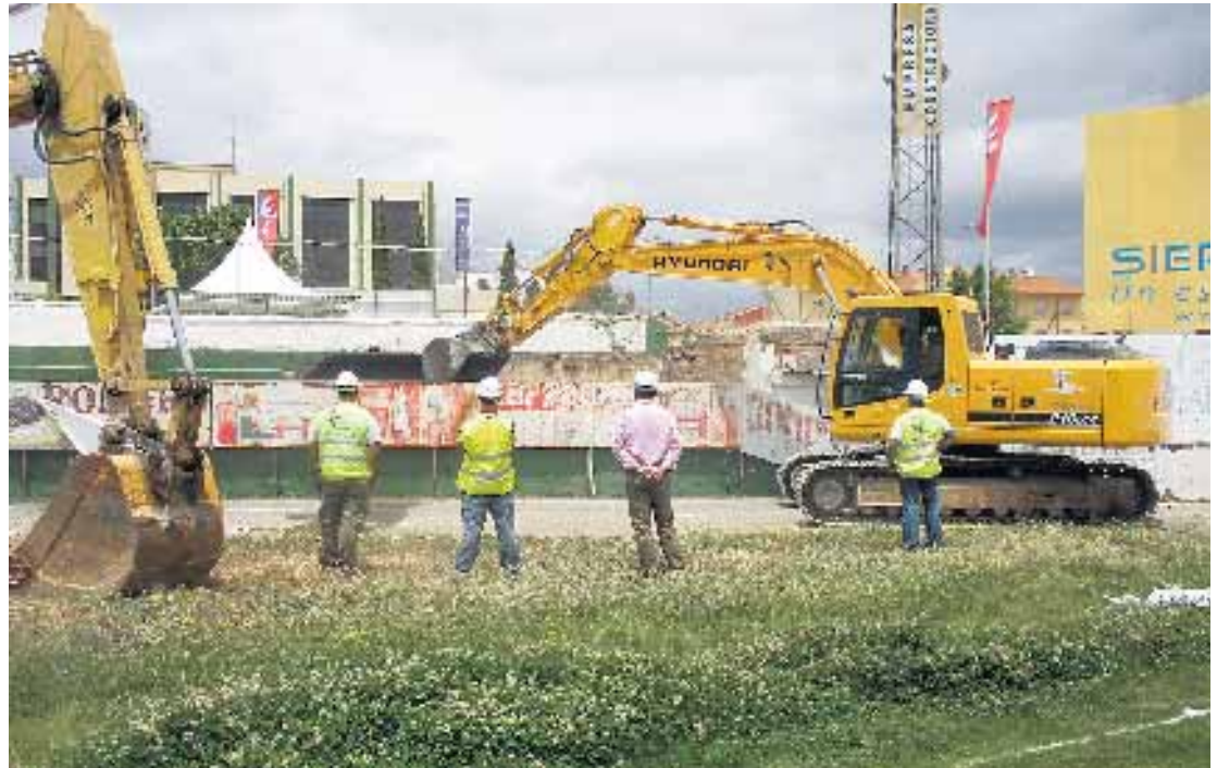
DEMOLICIÓN. El campo de fútbol, sobre el que irá parte del proyecto, ya ha sido derribado. / PLT
